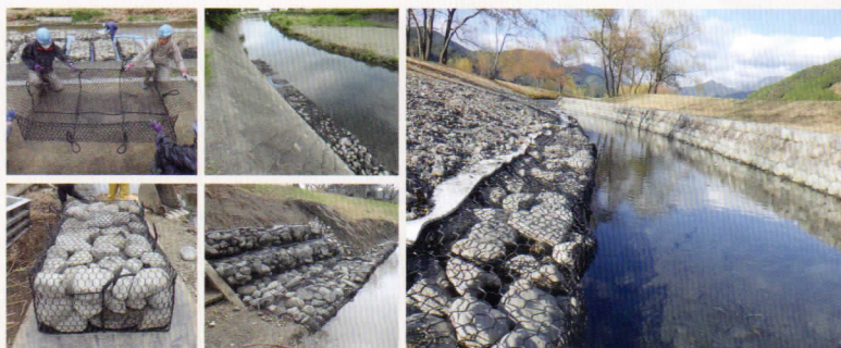
護岸造成や補強工事で活用
