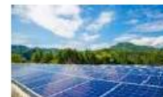
太陽光発電システム
