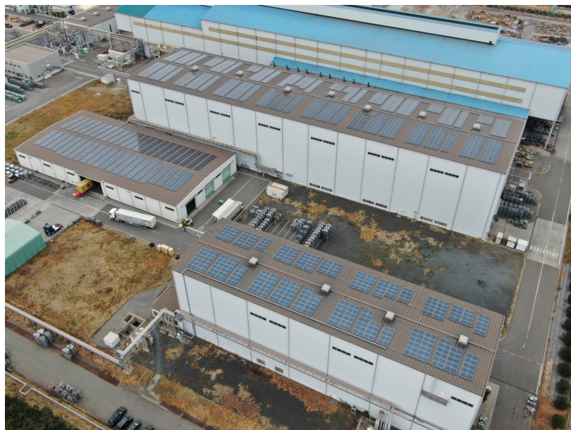
若松工場の屋上に設置した太陽光発電設備
