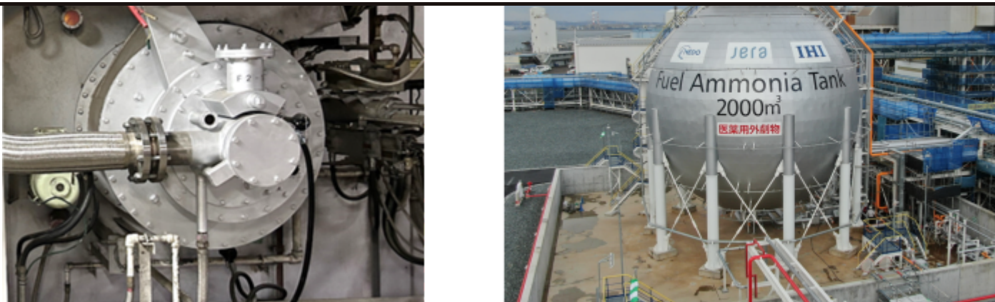
図2 実証用試験設備 (左：実証用バーナ 右：燃料アンモニアタンク)
